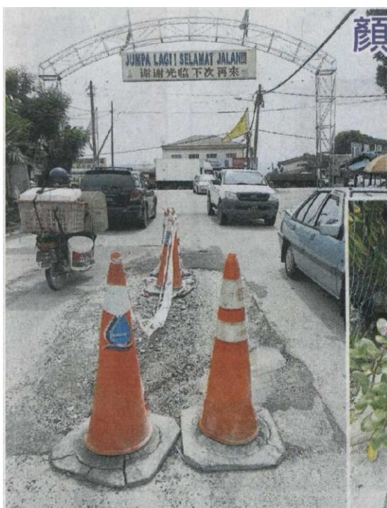
水供公司在新村主要人口处，挖路找破裂的水管已两周。
